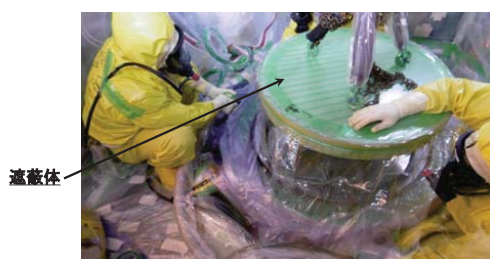
1次冷却設備のガス循環機(HGC)上部ケーシング ガスケット交換作業の様子 (品質保証管理要領に従い10年毎に交換)
